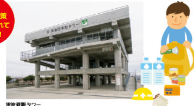
津波避難タワー
