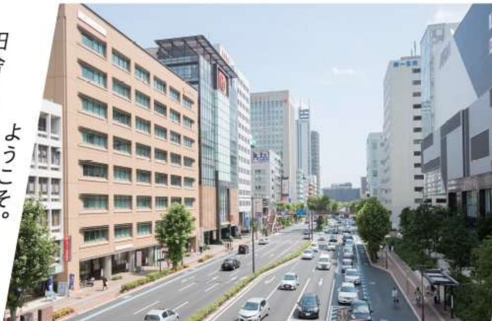
▲岡山駅前から向かい向かう「市民協賛局、市民協賛会、東はくろくビル」の様子。
