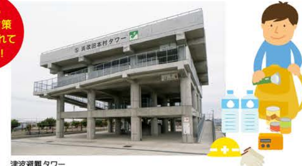
津波避難タワー
